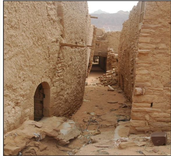
بعض الأزقة تتدرج في ميلها الطبيعي نحو الشرق لتفضي بمياه الأمطار إلى المزارع
