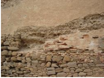
الصورة 05 : طريقة ترميم سور الطابية
