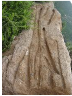
الصورة 04 : آثار الأزرع الخشبية المثبتة في سور لتقويته
