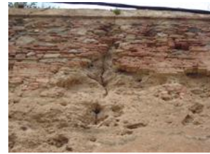
الصورة 08: طريقة حماية السطح الخارجي لسور الطابية
