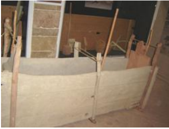
الصورة 01: قالب تقنية الطابية في المغرب الأقصى
