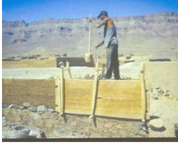
الصورة 03 : طريقة ملء القالب ودك التراب المدكوك داخله
