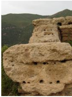
الصورة 04 : آثار الأزرع الخشبية المثبتة في سور لتقويته
